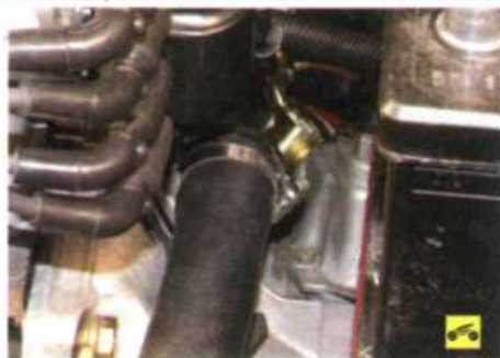
6. ...и с водораспределительной трубой.
